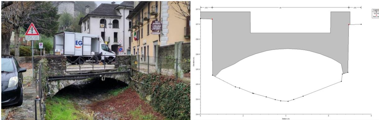
Figura 29 – Ponte di Piazza Chiesa ripreso da valle (sx) e geometria inserita nel modello idraulico (dx)
