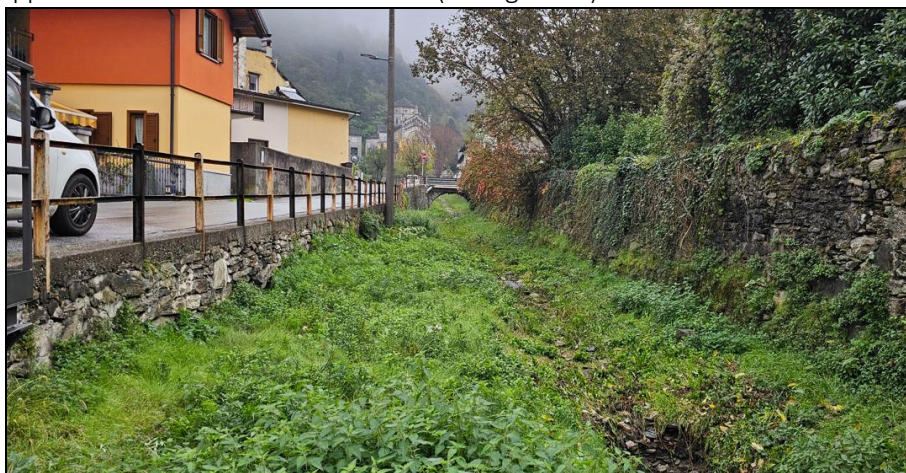
Figura 26 – Ripresa fotografica, da valle verso monte, del Rio delle Chiese a valle di Via Nazionale
